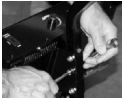
Montaje del gabinete de control
